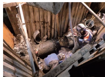
緊急工事による管切断状況
