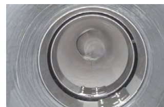
管内更生完了
