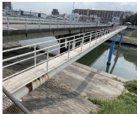
汐入橋水管橋
