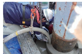
モルタル充填状況
