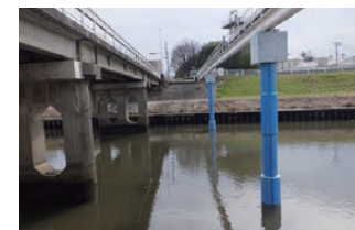
杭耐震補強完了
