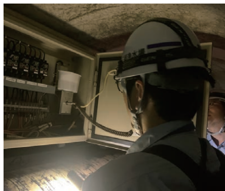
トンネル内電気設備点検状況
