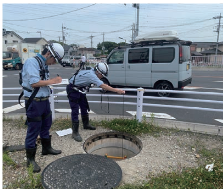
トンネル点検口酸素濃度確認状況
