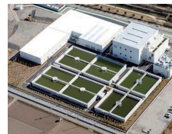
大久保浄水場排水処理施設(PFI事業)
