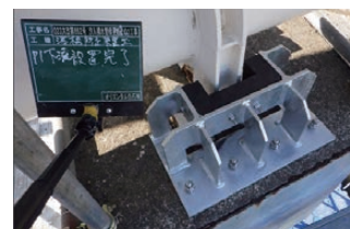
落橋防止装置設置完了
