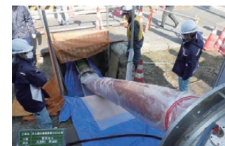
管内更生状況
