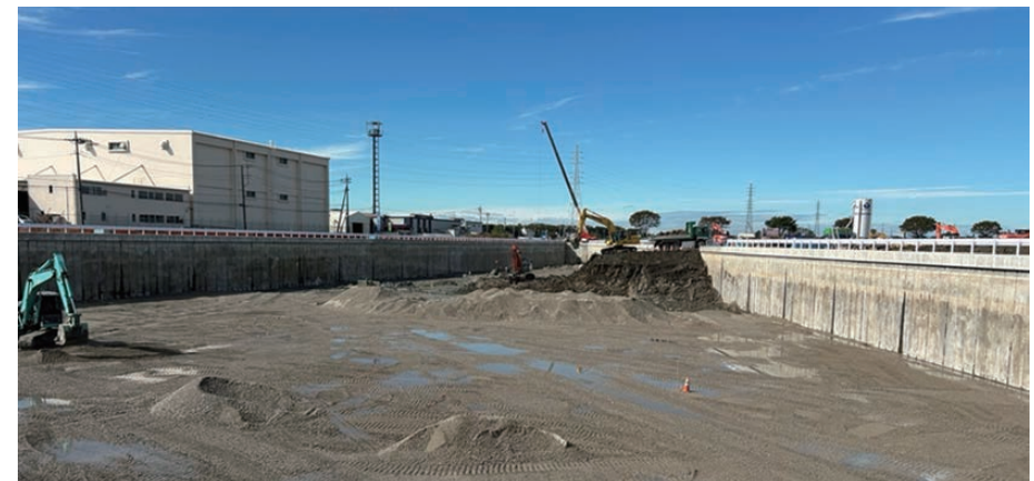
調整池工事における再生砕石の活用
