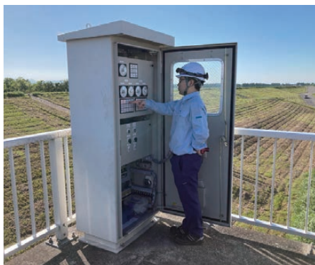
施設点検状況
