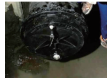
緊急工事による管栓帽設置状況
