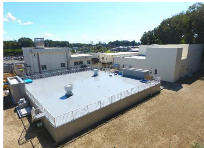
写真4 中継ポンプ所施設能力増強
