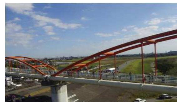
写真8 荒川水管橋見学会
