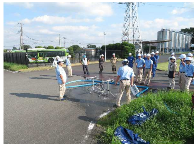
写真2 事故発生時の対応（応急給水栓の設置）
