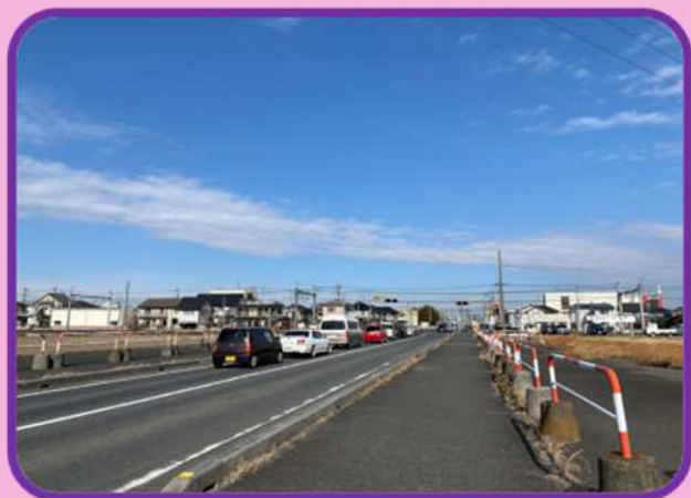
鴻巣川島線 JR高崎線の踏切付近
