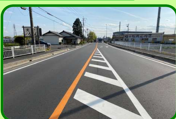
舗装の修繕後
