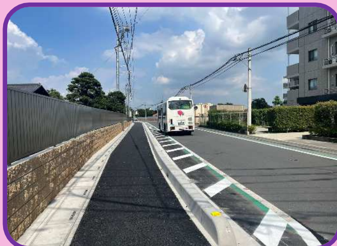
上尾環状線（小室工区）
