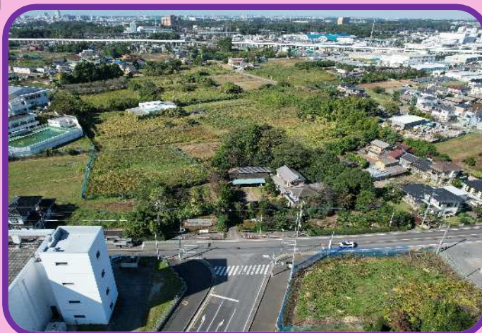
蓮田鴻巣線（小室工区）
