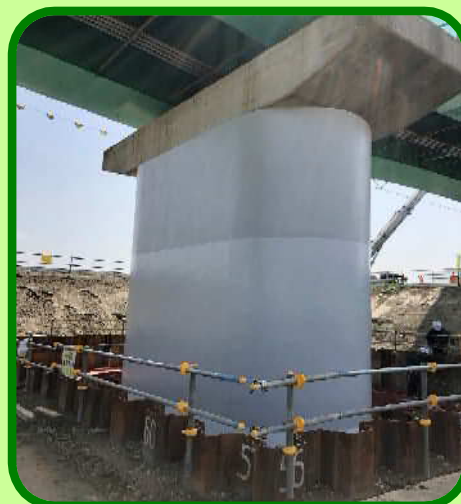
【耐震補強の例】 鴻巣川島線（糠田橋）
