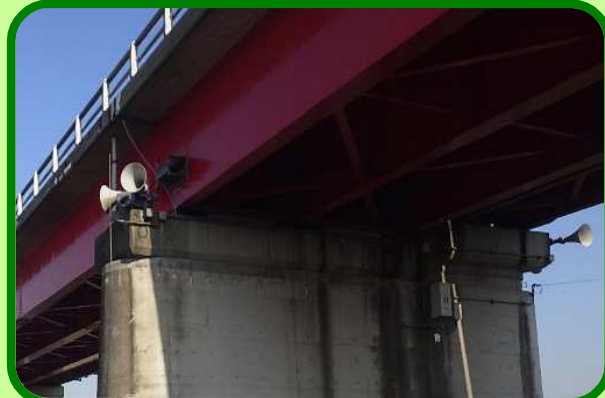
御成橋の塗替え後
