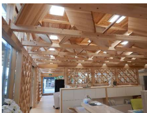
西川材を活用した民間施設（飯能市）
