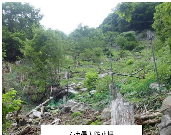
シカ侵入防止柵
