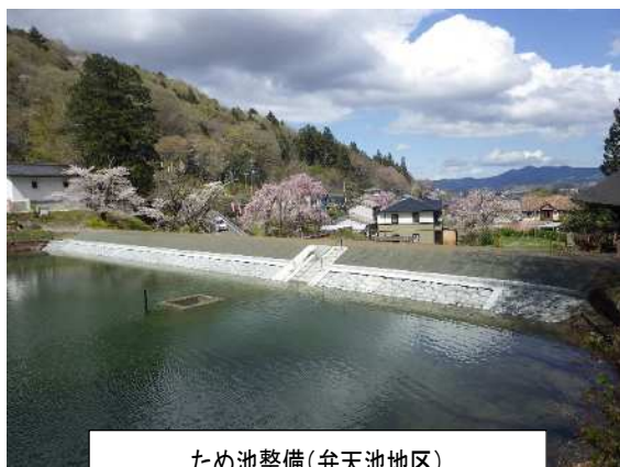
ため池整備(弁天池地区)
