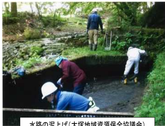
水路の泥上げ(大塚地域資源保全協議会)
