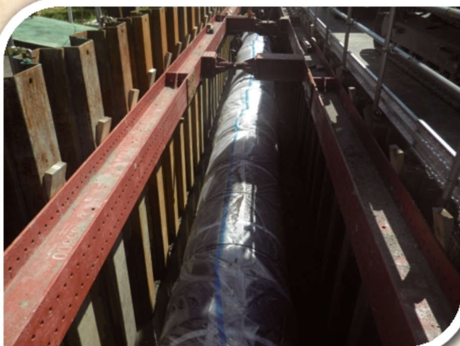
柿木浄水場場内配管更新工事 配水管布設(草加市)
