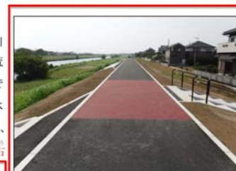
元荒川の遊歩道の整備（越谷市）
