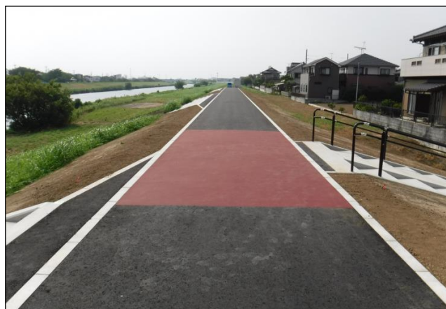
元荒川の遊歩道の整備（越谷市）
