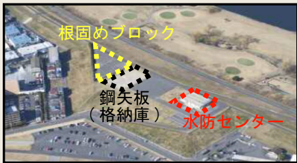
▲河川防災ステーション
