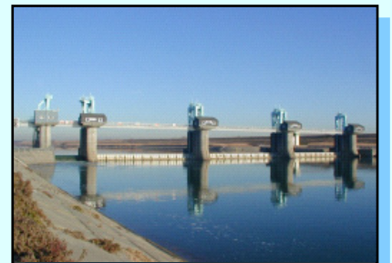
▲秋ヶ瀬取水堰(昭和40年完成)
