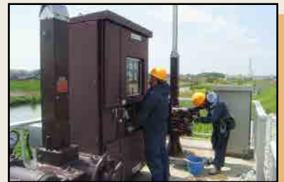
▲河川管理施設の点検状況
