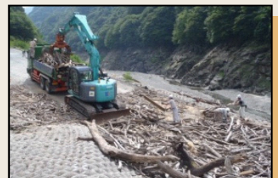
▲流木処理の状況
