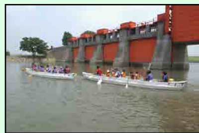
▲歴史的な施設(旧岩淵水門)
