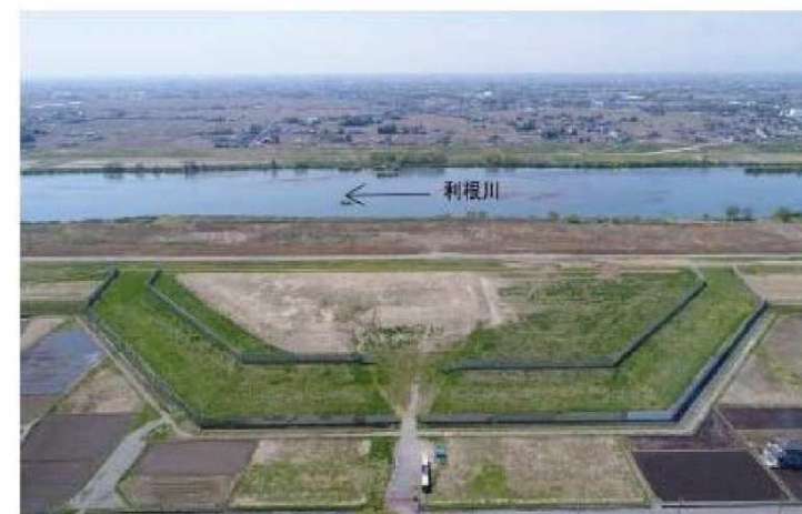
栄地区広域避難地(埼玉県加須市)
