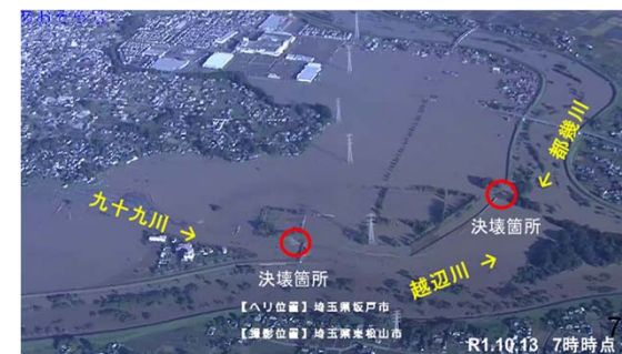
入間川流域における浸水被害状況
