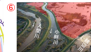
越辺川右岸0.0k付近
