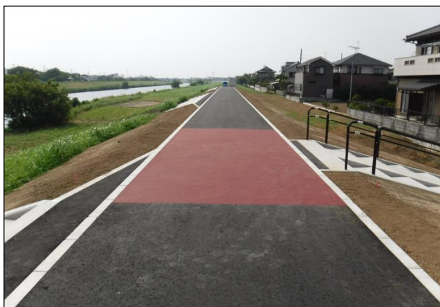
元荒川の遊歩道の整備（越谷市）
