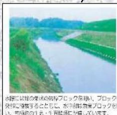
河床には石の集積の防止ブロックを埋め、ブロック中央部に砂を溜めるとともに、水中に浮き床ブロックを用い、河床の凹凸を、生態環境に配慮しています。
