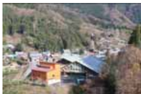
「ちちぶバイオマス元気村発電所」
