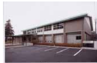
「川本南小学校体育館：外観」
