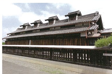
競進社模範蚕室(県指定建造物)
