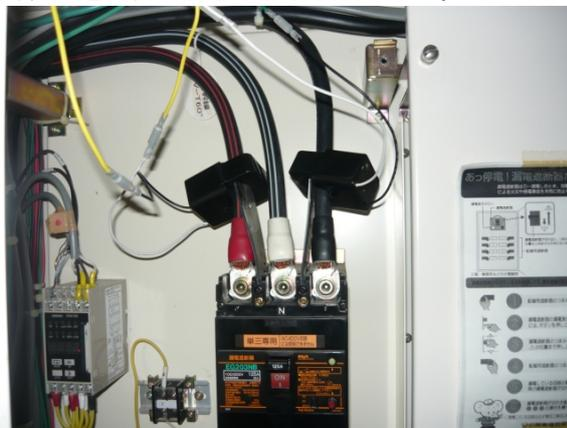
図3 電流測定器 (CT設置)
