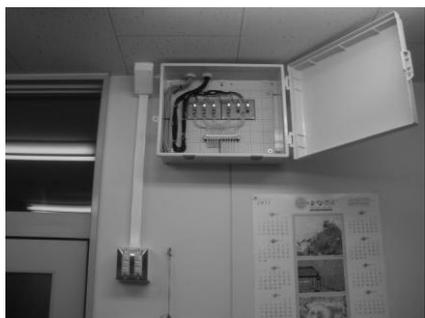
図7 設置したメカニカルリレーと切替スイッチ
