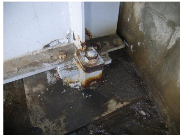
(支承部の劣化事例)
