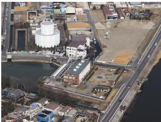
【排水機場全景】
