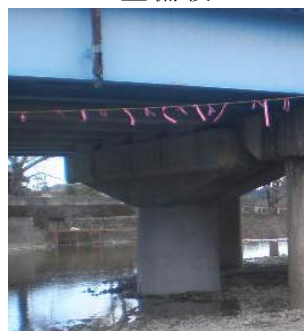
橋脚補強（鉄筋コンクリート巻立て）の例
