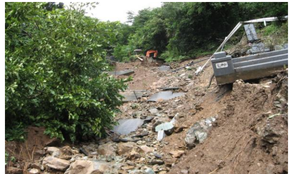
H19.9 神川町で発生した土砂災害
