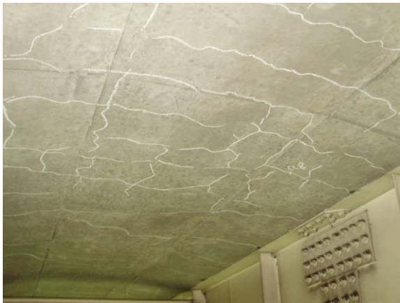
(床版の劣化事例)
