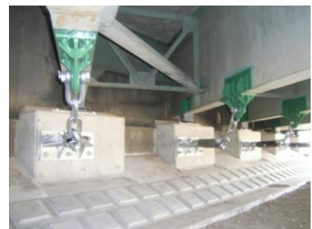
落橋防止装置（チェーン）の例
