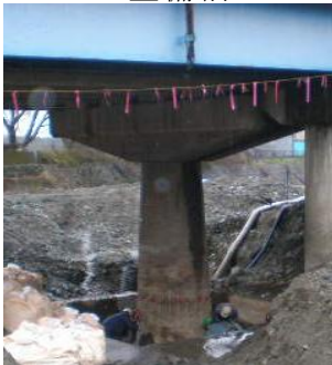
橋脚補強（鉄筋コンクリート巻立て）の例
