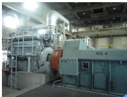
【排水ポンプ設備外観】
