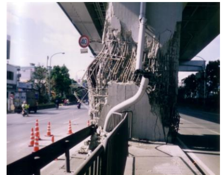
阪神・淡路大震災での損傷事例
