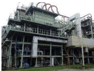
荒川水循環センター 汚泥焼却炉設備
