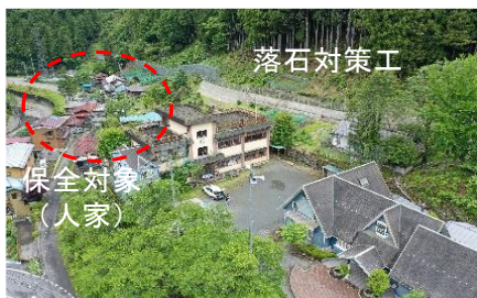
砂防関係施設整備
