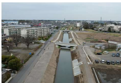
河道整備（河川拡張）
