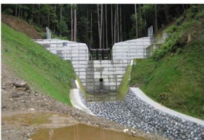
砂防関係施設整備
