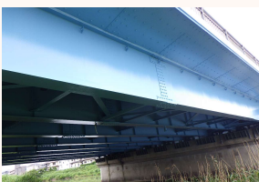
橋りょう修繕
