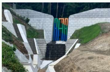
砂防関係施設整備
