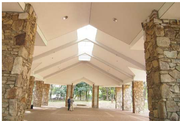
【大型休憩舎】面積約460㎡での休憩舎、災害対応避難施設です。
