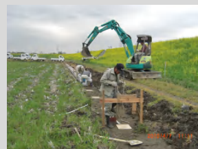
素堀り水路から コンクリート水路への更新
