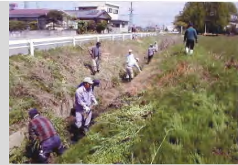
水路の泥上げ
