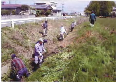
水路の泥上げ（熊谷市太田中部地区）
