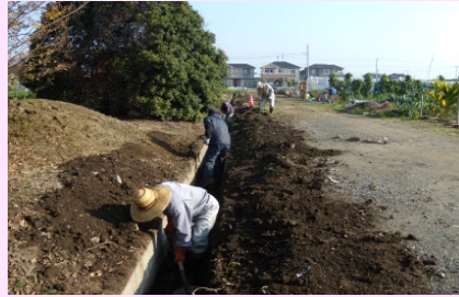
水路の泥上げ
