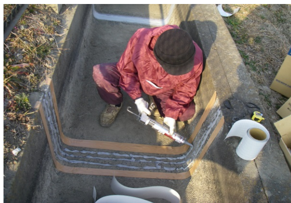
御正堰地域農地・水・環境保全 管理協定（熊谷市）
