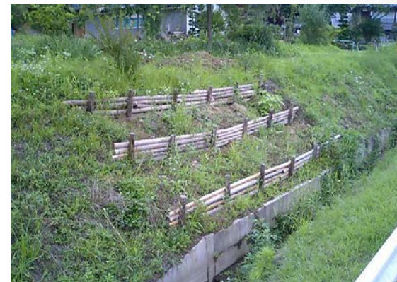
【水路法面の復旧状況】
