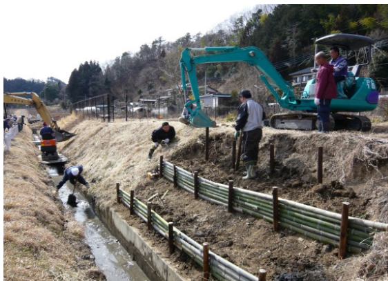
【法面の補修作業】
