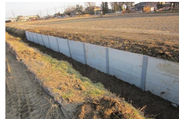
水路の整備 (完成)
