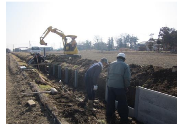
水路の整備 (施工中)
