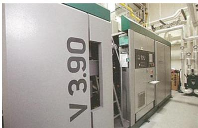
ペレットを不完全燃焼させガス化
