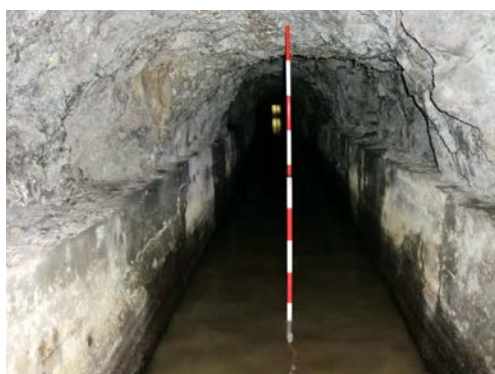
現況（未覆工箇所）
