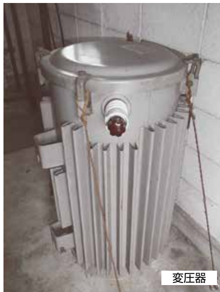
写真5-2 高濃度PCB廃棄物（変圧器、コンデンサー及び蛍光灯安定器）
