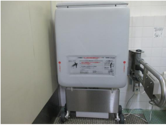
A棟1階男子トイレ1
