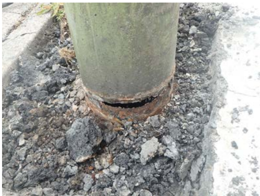
SCFR工法 施工前
