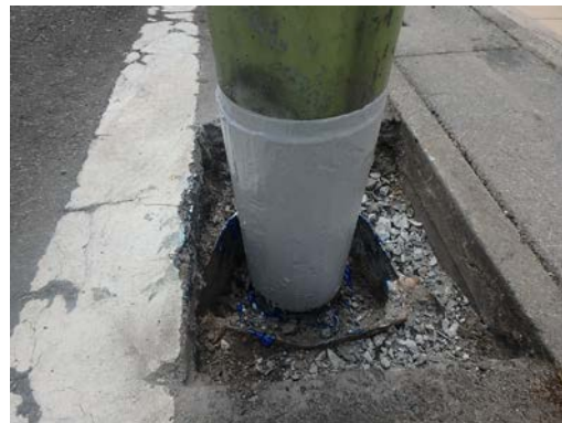
SCFR工法 施工後
