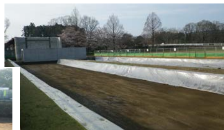
道路土工の基礎地盤置換材(日高市内)
