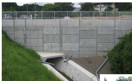
補強土壁工の盛土材(飯能市内)
