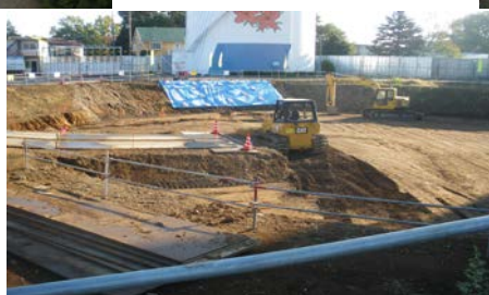
配水タンクの基礎地盤置換材(狭山市内)
