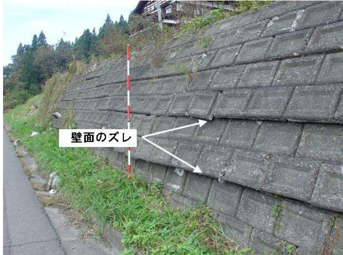
水平方向にせり出しが生じたブロック積擁壁：※
