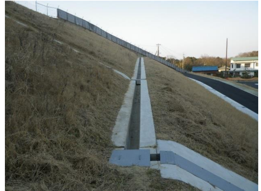
法面排水の例
