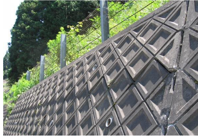
水平方向にせり出しが生じたブロック積擁壁：※
