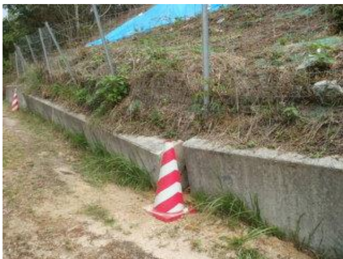
地山の押出し・打継面のズレ
