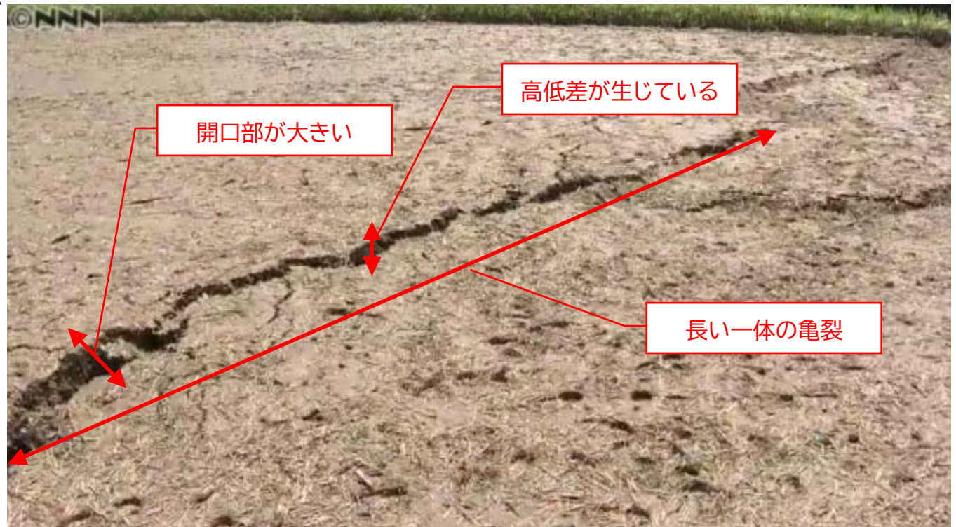
著しい不陸・傾斜・陥没・地割れ等
