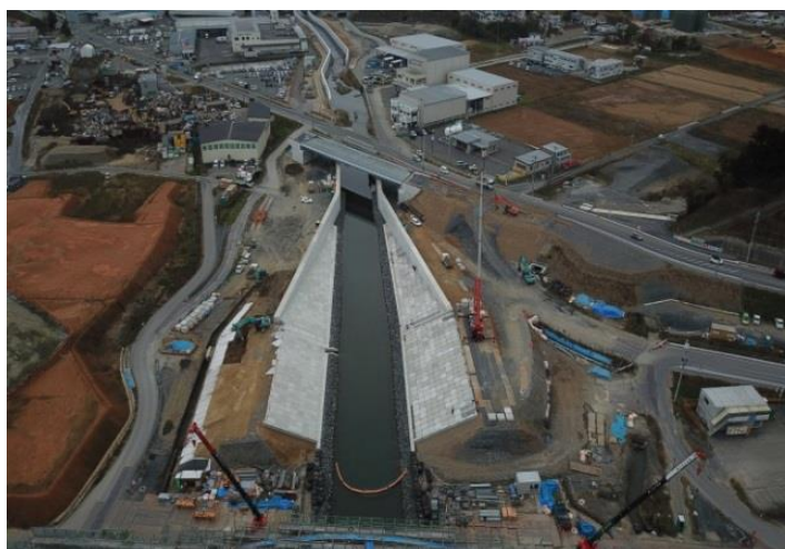
瀬川災害復旧工事(平成 29 年 11 月末現在) 盛土築堤にブロックを張る作業が進行中
