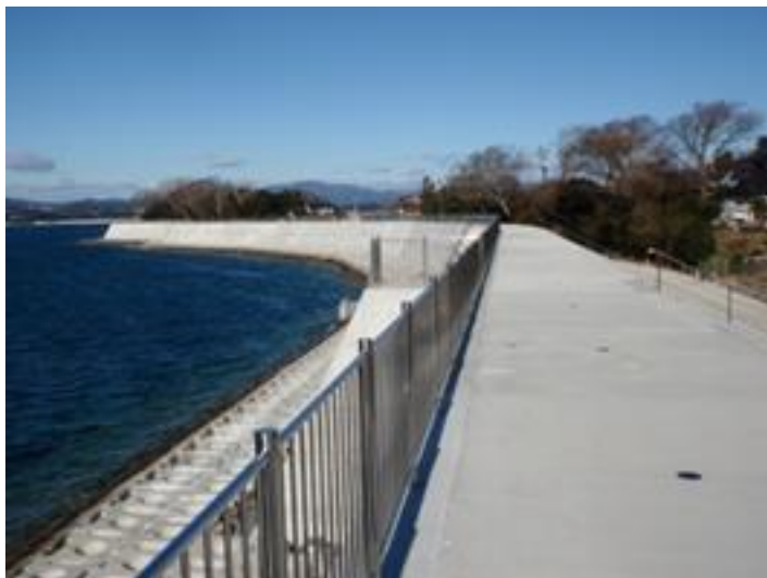
11 月に竣工した中沢海岸復旧工事
