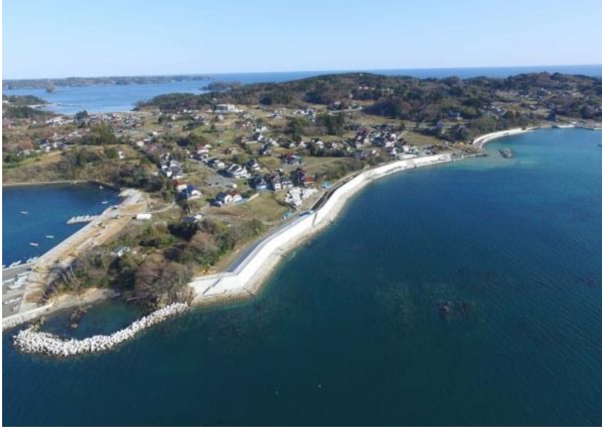
11月竣工予定の担当している気仙沼大島地区中沢海岸防潮堤災害復旧工事の全景 延長 L=715m 設計金額 C=29億円
