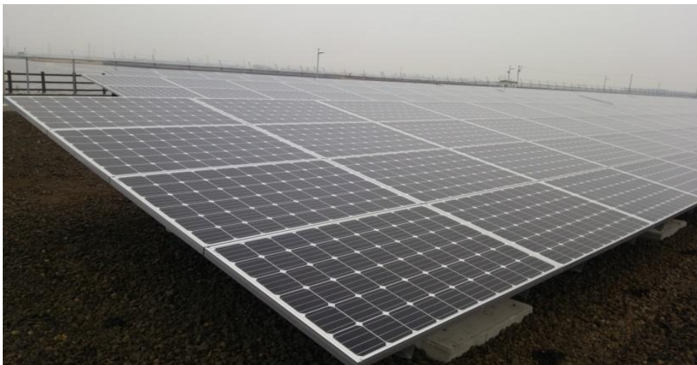
岩沼市藤曾根地区太陽光パネル
