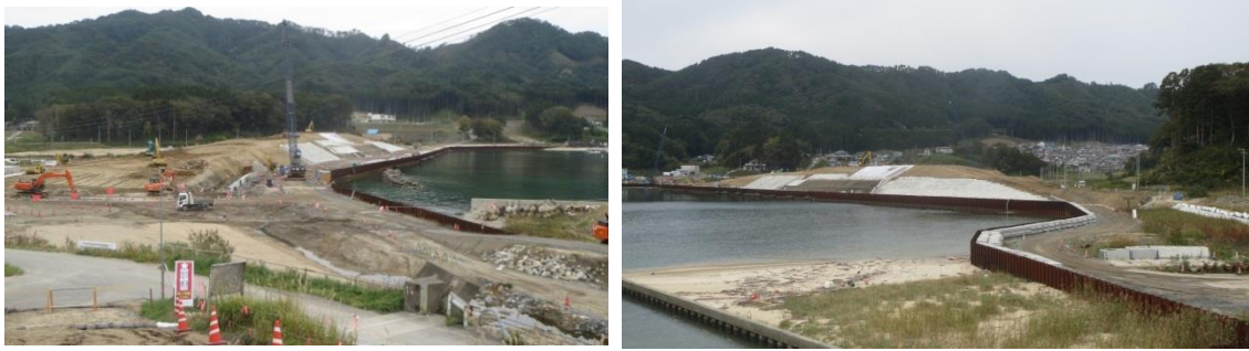
防潮堤復旧工事の様子（山田町船越地区）
