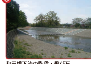
和田橋下流の階段・飛び石
