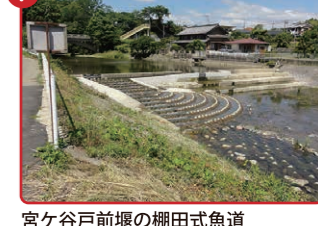
宮ヶ谷戸前堰の棚田式魚道
