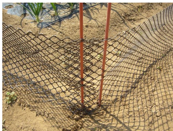
図10 角部は支柱を増やして補強
