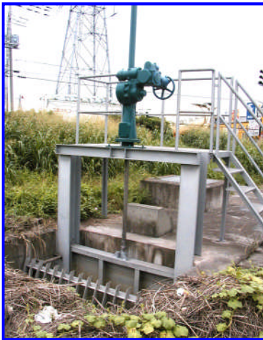
取水口(呑口側)
