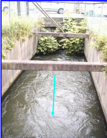
取水口(吐口側)
