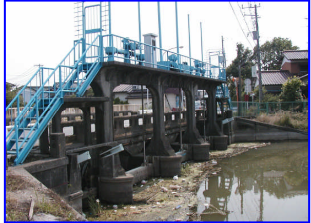
鴻巣市安養寺地先 ※安養寺堰の完成に伴い、平成18年1月に撤去された
