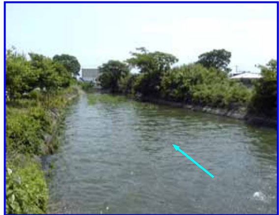
深谷市内ヶ島地先
