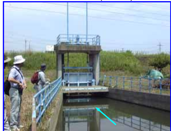
深谷市上敷免地先
