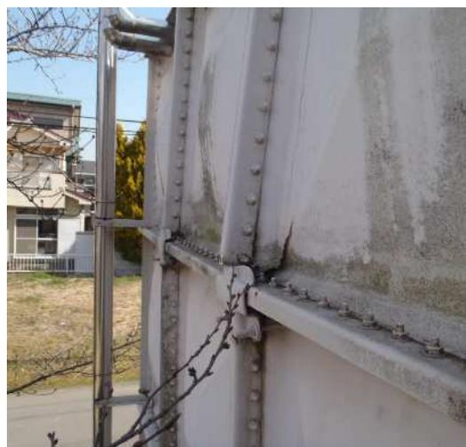
貯水槽に接続している配管が破損し、外れてしまっている状態です。
