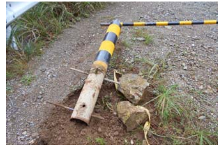
車で引き倒されたゲート
