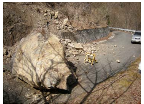
法面崩落により、落石が道路を寸断
