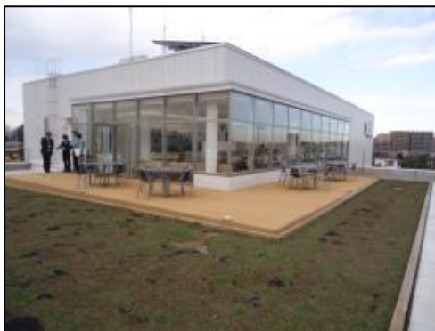
屋上緑化(入間ガス)
