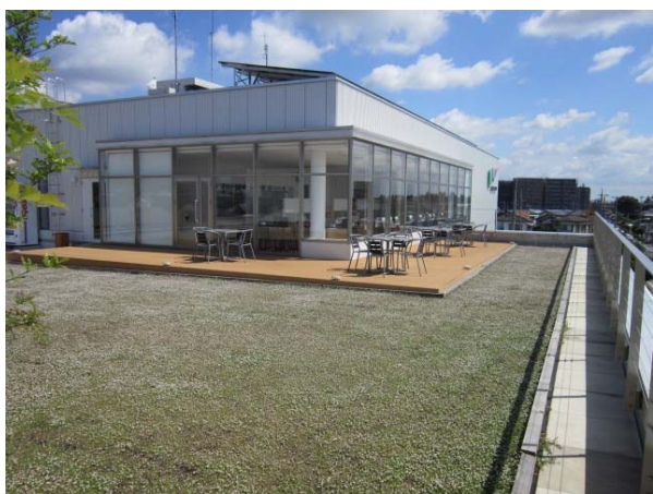
屋上緑化 (H25 入間ガス(株))
