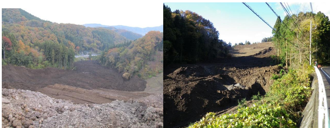
盛土崩落事故直後の写真
