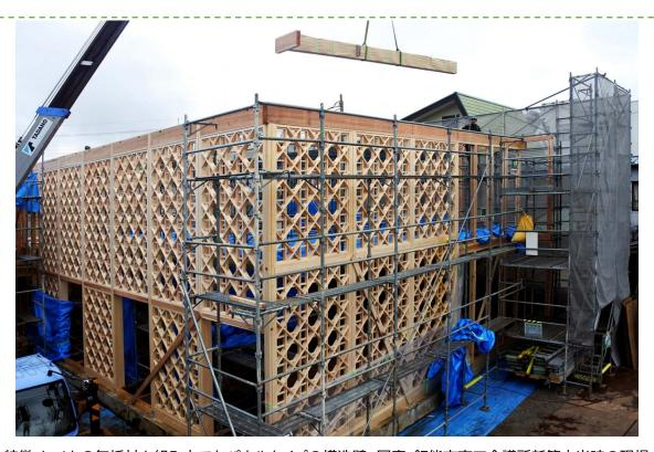
特徴:ヒノキの無垢材を組み立てたパネルタイプの構造壁 写真:飯能市商工会議所新築中当時の現場
