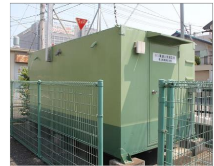
大気測定局 局舎（外観）
