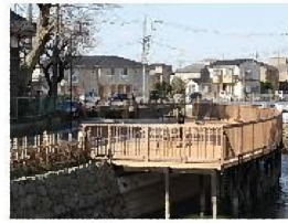
①東京葛西用水 (久伊豆ゾーン)
