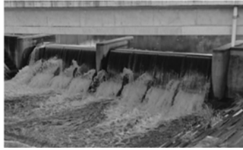
写真2 堰の状況 (9月3日、転倒前)
